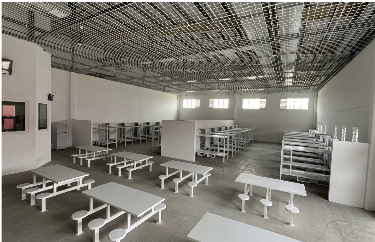
Fig. 15. Nuevo Complejo Penitenciario Federal VII: Alojamiento colectivo 74
